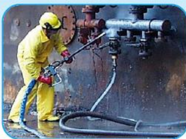
Préparation de surface de vannes multiples
