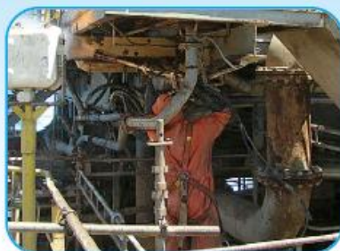
Préparation de surface en mer à bord d'un appareil de forage auto-élévateur
