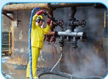
Préparation de surface d'une tuyauterie complexe
