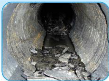
Détartrage de conduite large – 200 l/min et 1000 Bar
