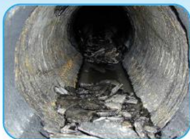
Détartrage de conduite large – 200 l/min et 1000 Bar
