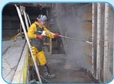
Nettoyage de surface dans une aciérie – 33 l/min et 500 Bar
